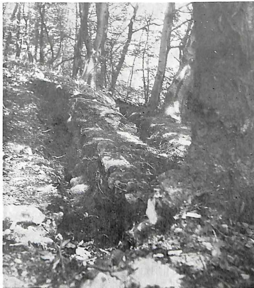
Sl. 42. Kozolin, dio zida otkopan 1970. god.
