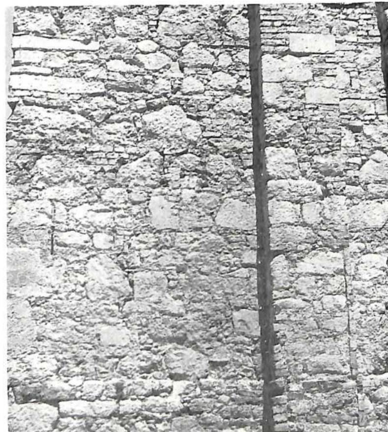
Sl. 7. Moravče, građa zida crkve sv. Trojstva (danas pod žbukom)
